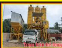
Trạm trộn bê tông
